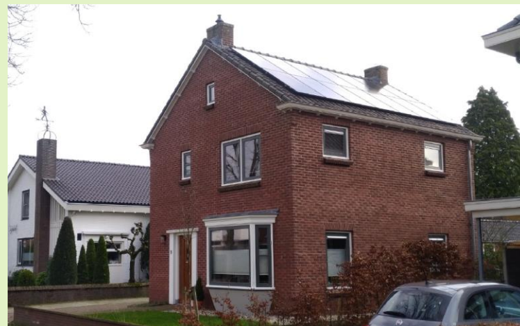
14st PV panelen op ZW dakvlak (opwek 4300kWh in 2022)
